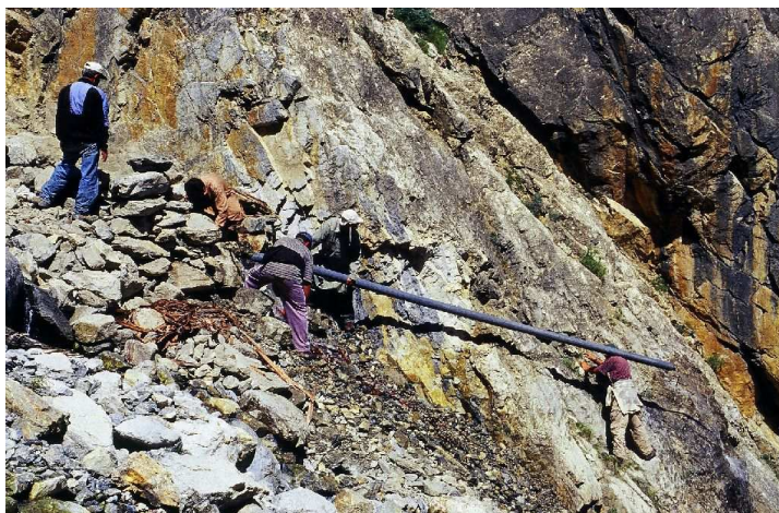
Das erste eigene Projekt: Wasserleitung für das Dorf Passu in Hunza – schwierige Bauarbeiten
